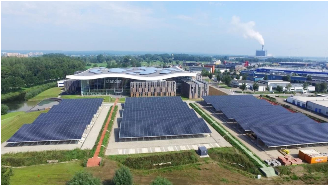
Figuur 17 ZonPV geplaatst als overkapping parkeerplaats bij Alliander in Duiven
