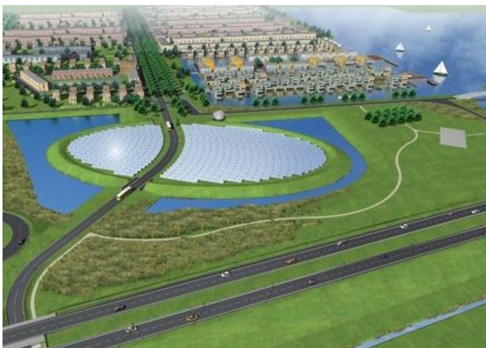
Figuur 22 Zonnewarmte eiland van Nuon in Almere, aangesloten op stadsverwarming 0,7 ha collectoroppervlak, 1,5 ha grondoppervlak. Productie 10 TJ per jaar.
