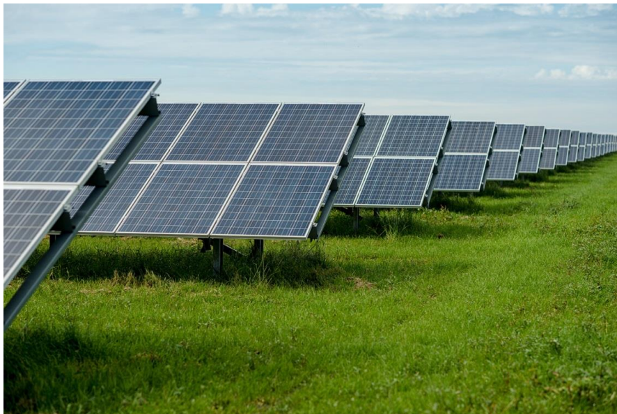
Figuur 20 Zonnepark Ameland, opbrengstverwachting 5,6 GWh per jaar bij 6 MWpiek. Opbrengst in het eerste jaar 7,1 GWh (1.180 vollasturen en 0,7 GWh/ha) http://www.duurzaamameland.nl/uitstekend-eerste-jaar-zonnepark-ameland/
